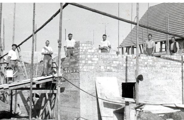
Fleißige Mitarbeiter beim Rohbau der neuen Kirche in Undingen, 1955
